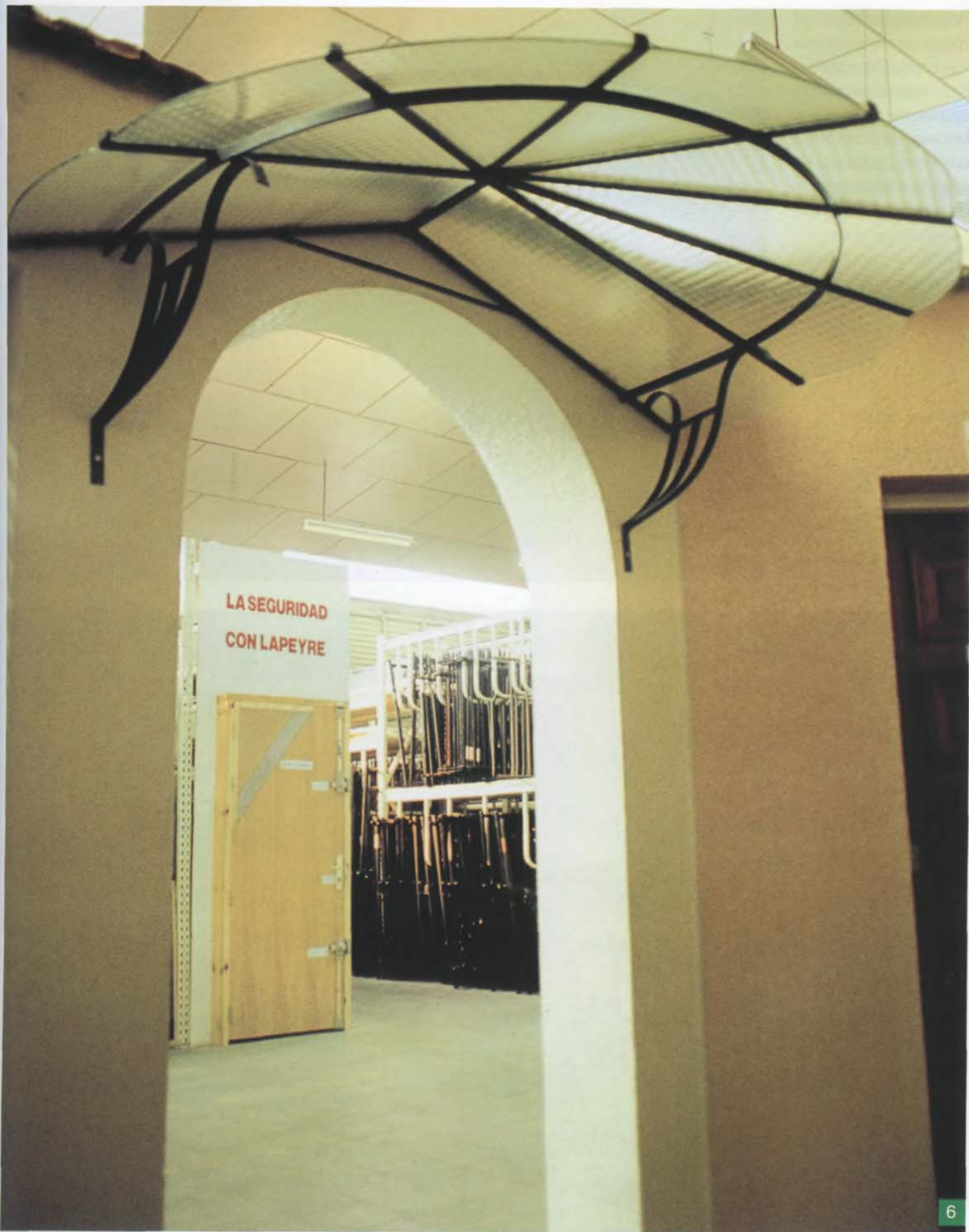
Элегантный козырек над входом выполнен из армированного стекла и металла (6). На фото 3 и 5 представлены фрагменты конструкции.
